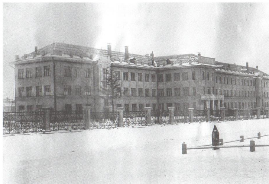
Городская больница и помещения госпиталей № 2431, 5932.
